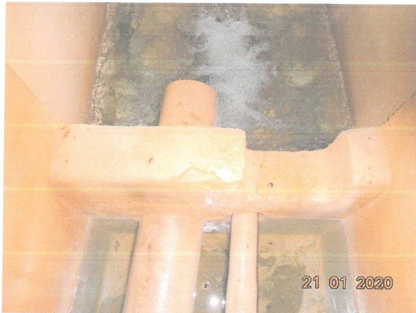
Сн.5. Вътрешен изглед на водоземането и сухата камера
