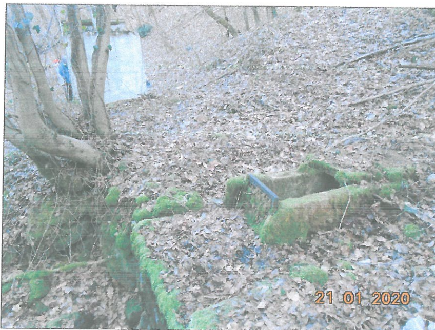
Сн.3. Външен изглед на преливния канал от КИ
